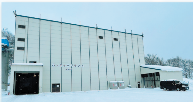
写真 冬期寒冷地のコンクリート製造設備
